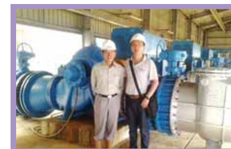
我公司DFSS型双吸泵在PT LAJUPERDANA TNDH公司泵房运行 型号为：DFSS500-640A，Q=3700M³/H，H=35M，N=450KW 安装时间：2009-3，6台
