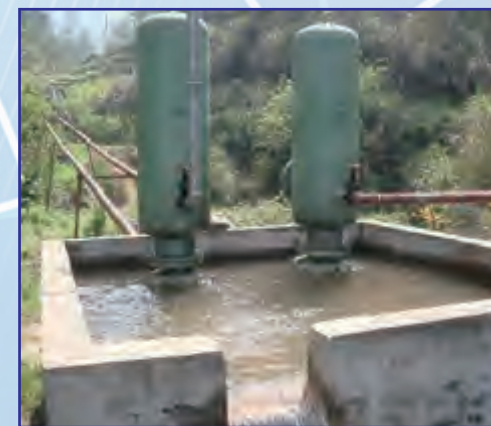
图3 正在工作的水锤泵
