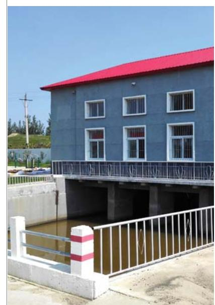
沈阳市辽中区辽浑蒲泵站在大型泵站更新改造规划中为 14 座排水站，其中 9 座排水站，已于 2010-2012 年利用发改和水利资金改造维修，目前基本能够正常使用。故列入本次更新改造的泵站共 5 座，包括老大房排水站、丁家、暴家沟、下万子、金山站。共装机 33 台，总装机容量 3770kW，总设计流量 38.8m<sup>3</sup>/s。工程区位于辽中县，地处辽河流域下游，隶属于沈阳市，位于沈阳市西部，属于辽河、浑河冲积平原。起伏很小，平均海拔高程 13.5m 左右，地势平坦。地形由东北向西南缓降，地面平均比降为 1/5000。东部一带有少数沙丘，西南部地势低洼。境内水系发育，主要有辽河、蒲河和浑河。泵站改造更新后有效的解决了附近村镇农田的汛期排涝情况。
